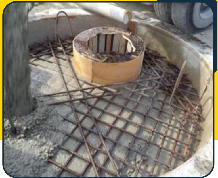
8 Coverslab Concrete Pouring
