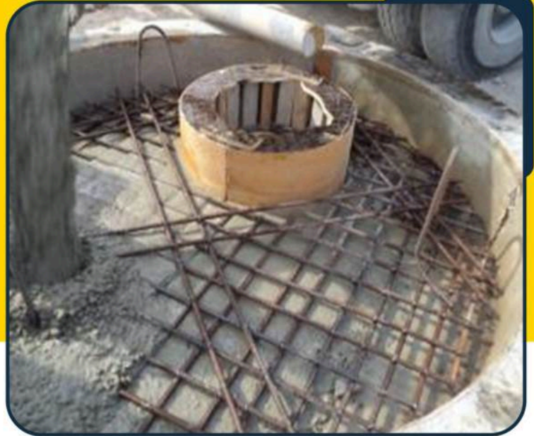
8 Coverslab Concrete Pouring
